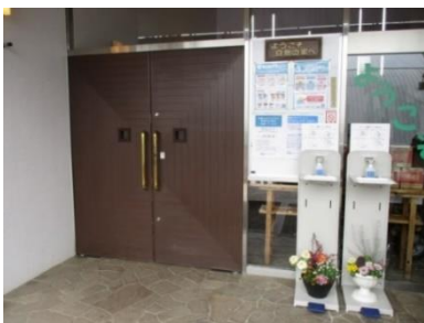
玄関前 足踏み式手指消毒設備
